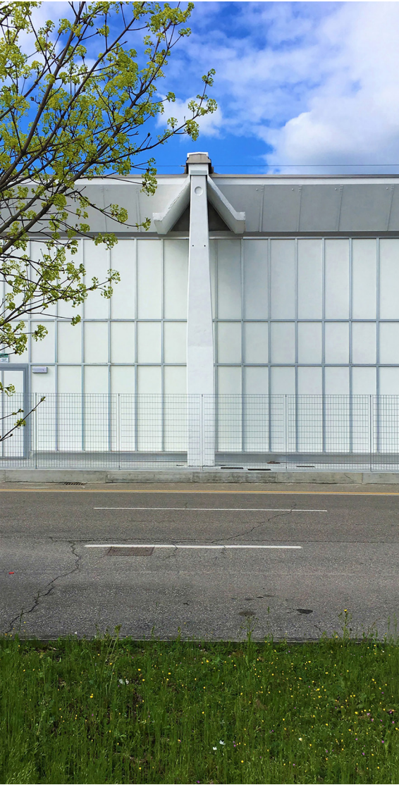
Dettaglio della struttura portante dello stabilimento a Crema.
